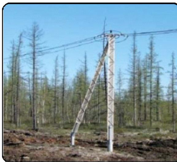
Рис. 2. Опоры из гнутого профиля и из круглой трубы (слева направо)
